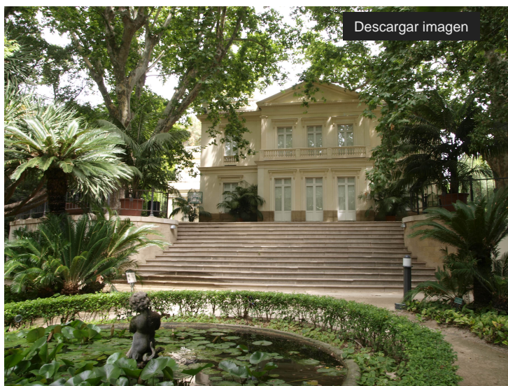
Vista de la fachada principal
